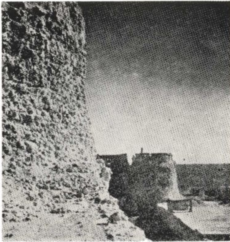
خندق و دیوار جداری قلعه پرتغالی هرمز
