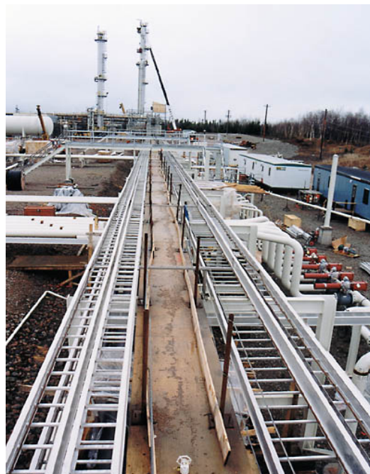
(شکل شماره ۲-۳-۱۰) Ladder Type Cable Tray کانالی
