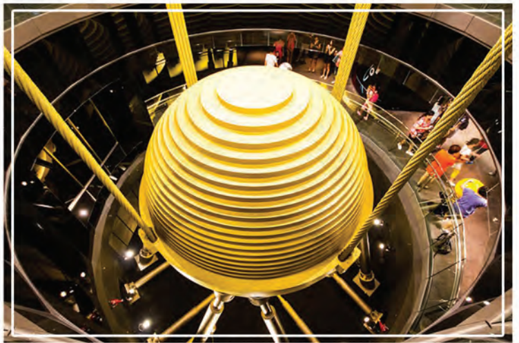
تصاویری از پاندول میراگر استفاده شده در تایپه ۱۰۱ برای جلوگیری از جابجایی بیش از اندازه برج ساخت تایپه ۱۰۱
