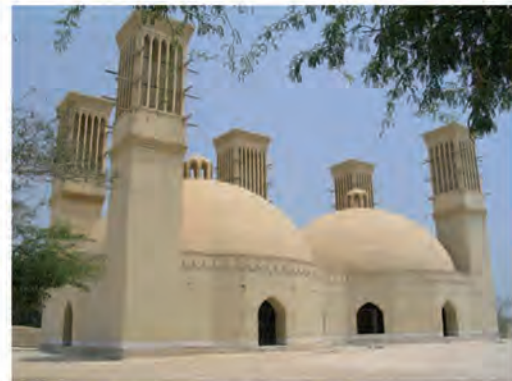
یک آب انبار پنج بادگیره با دو منبع ذخیره آب در جزیره کیش در اقلیم گرم و مرطوب
